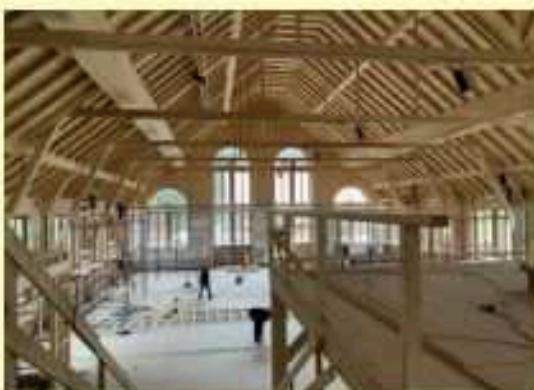
Während der Bauarbeiten für die Große Halle
