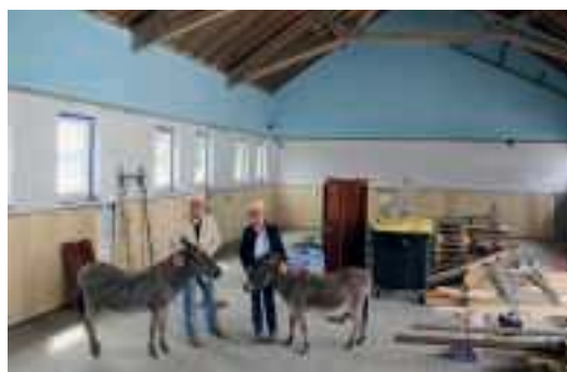
Wo einst Autos parkten, ziehen jetzt bald die Esel ein – die Ausbaurbeiten sind fast beendet
